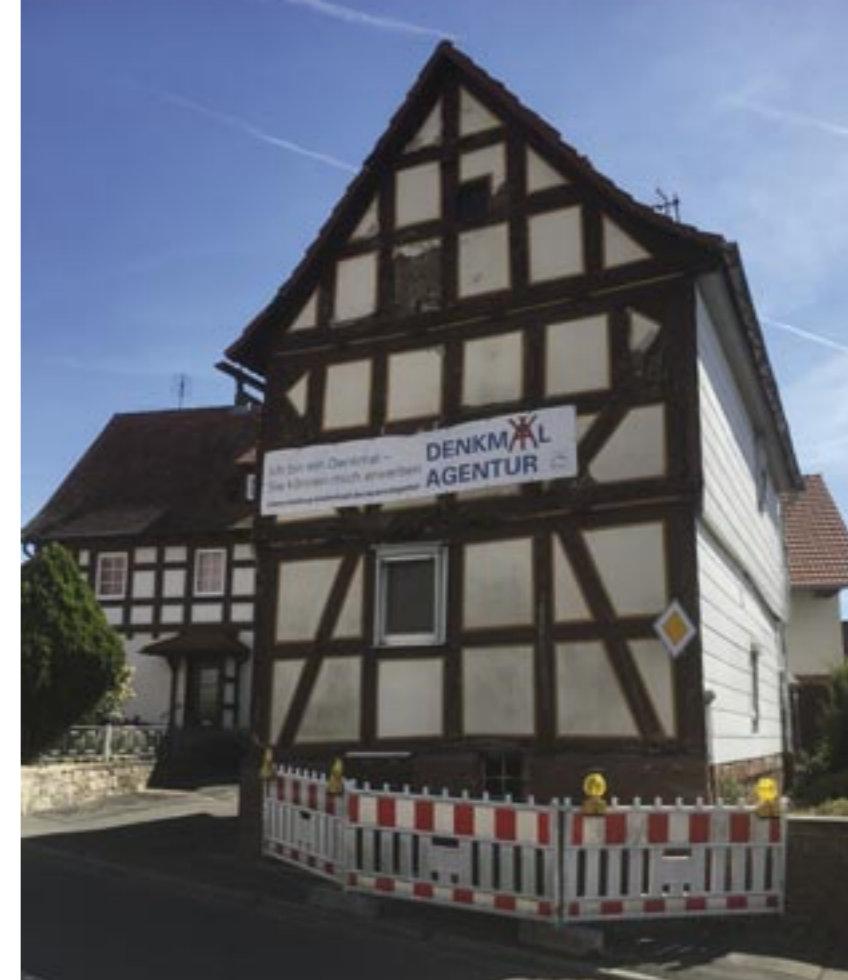
Das Tagelöhnerhaus in Rüdighheim war das erste Objekt, das die Denkmalagentur des Landkreises nach jahrelangem Leerstand vermittelte. (Fotos: Landkreis)
