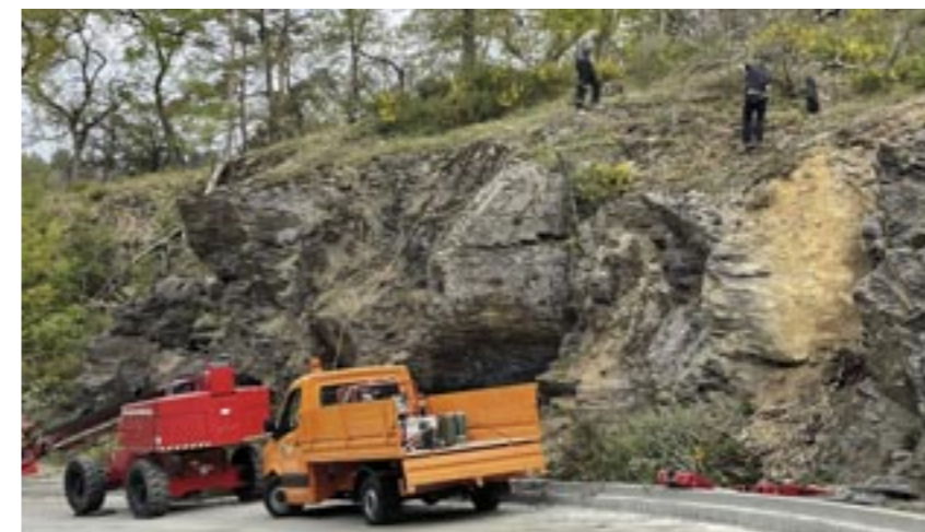
Gerade abgeschlossen wurden die Arbeiten an der Kreisstraße 117 zwischen Gladenbach und Kehlbnach. Dabei wurde auch der Hang unterhalb des Blankensteins gesichert. (Foto: Landkreis)
